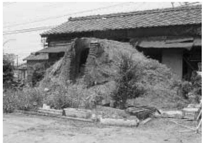
寿町のダルマ窯(大正時代に築造された瓦を焼く窯)
