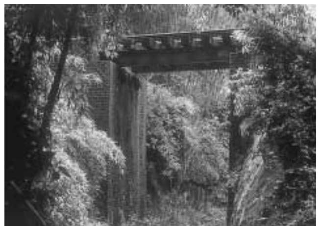
金谷下開渠(大正時代に築造された鉄道橋)
