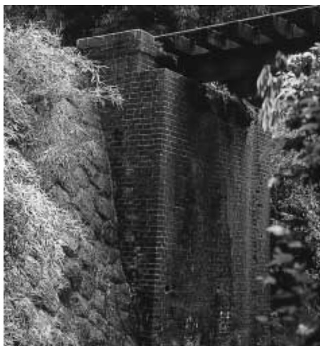
金谷下開渠の橋脚
