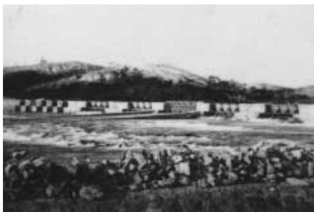
明治用水旧頭首工(2代目の取水堰) 明治用水真景絵葉書より
