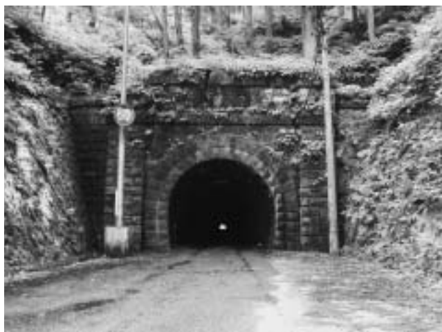
伊世賀美隧道(連谷町側から)
