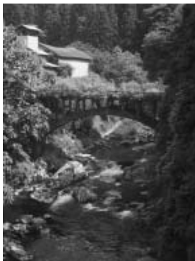
郡界橋(国道153号から)
