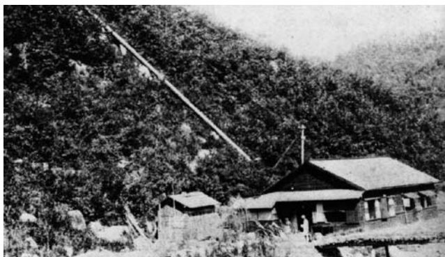
建設当時の岩津発電所（中部電力株式会社蔵）
