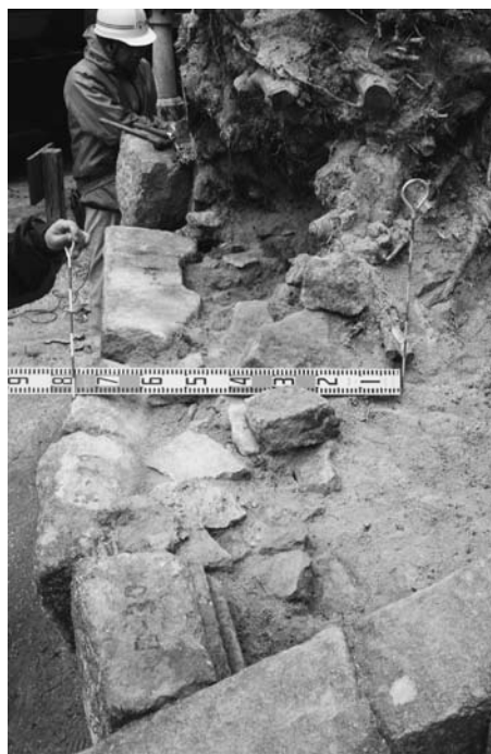
解体中の墓所入口の石垣
