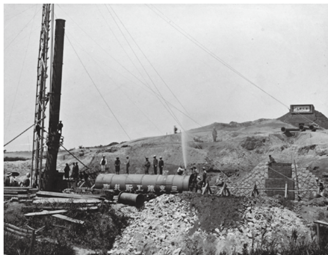
ボイラーを設置して試運転中の関係者。右奥は題額
