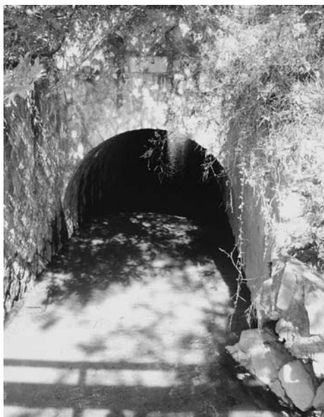
写真 葭池樋門 (鴛鴨町)
