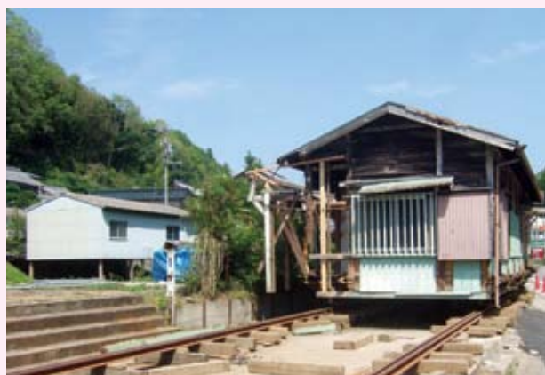
曳家工事の様子
